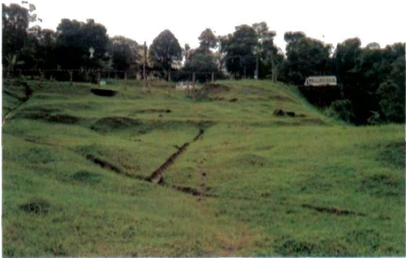
ඡායාරූපය 5.3 භූමිය මතුපිට සහ අභ්‍යන්තරයේ ඉදි කළ ක්‍රමවත් ජලවහන රටාවක් මගින් නායයෑමක් ස්ථාවර කර ඇති ආකාරය දැක්වෙන ඡායාරූපයක්.
