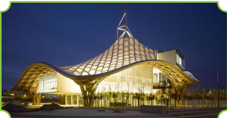
නව්‍යාකාරයෙන් උණගස් යොදා ව්‍යුහය සකස්කර තැනූ මෙට්ස් ඩී ෂෙයුර් බැන් හි “ද සෙන්ටර් පොම්පිඩොයු” ( www.feeldesain.com )
